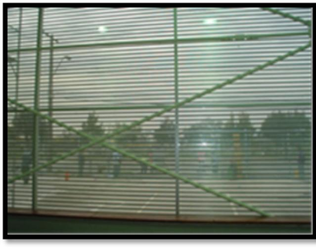
\* Placa de fierro galvanizado lisa en 0.8 mm. De espesor y perforaciones circulares de 3 mm. De diámetro con una visibilidad de 70% traslucido.
